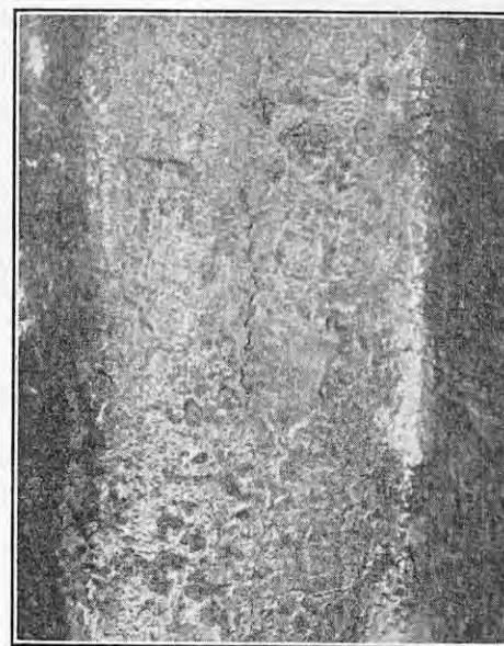
FIG. 2. LONGITUDINAL INGOT CRACK.
