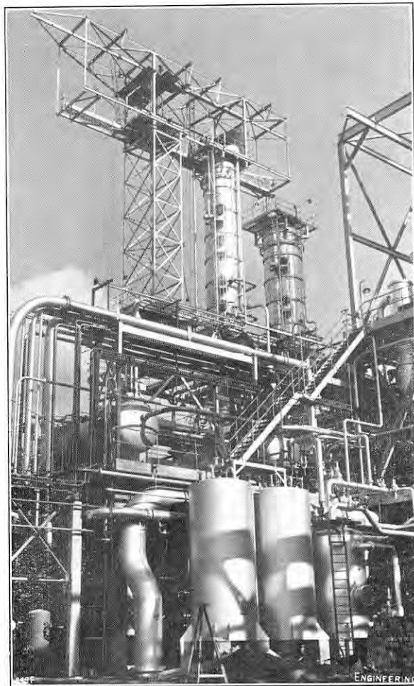
FIG. 7. COLUMNS C4 AND C5.
