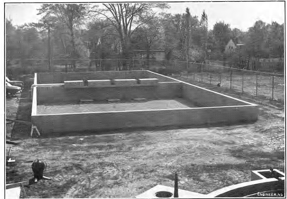
FIG. 12. SLUDGE BEDS.
